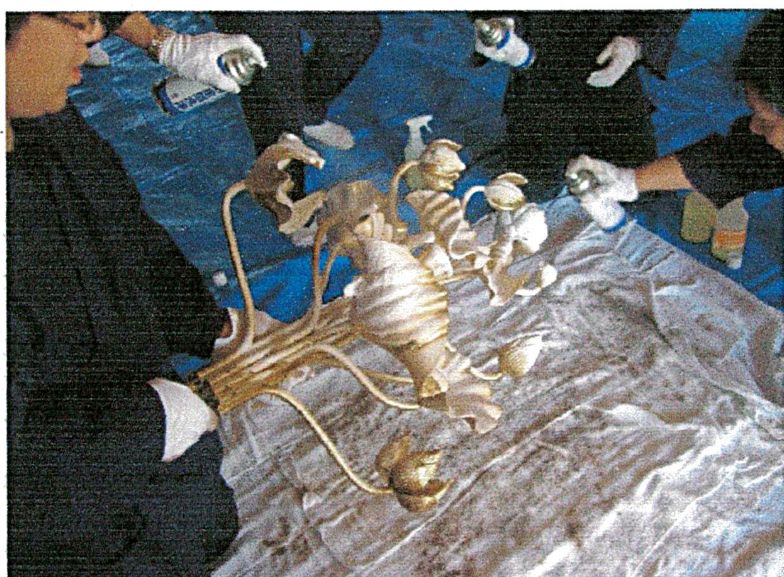
独自開発の泡洗浄工法。敷かれたタオルには瞬間に落ちた汚れが
