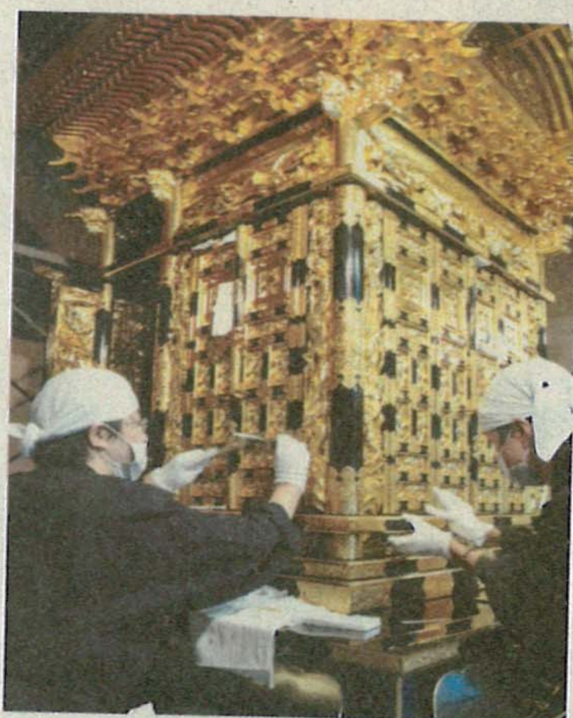
三宝尊像が安置されている宮殿の修復作業に取り組む職人
